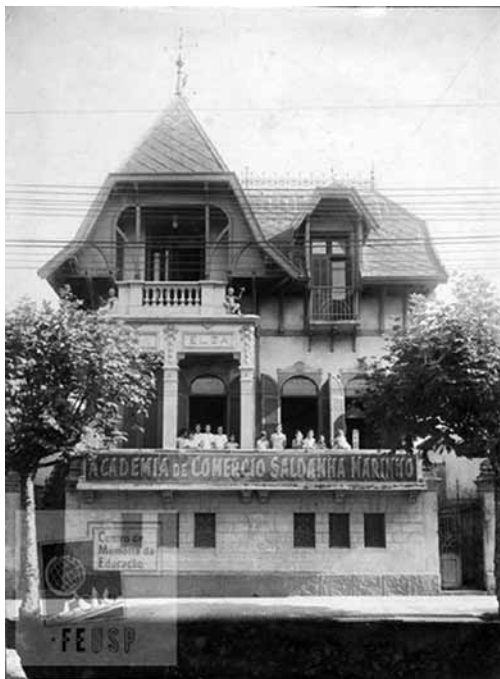
Figura 3: Fachada da Academia de Comércio Saldanha Marinho. Décadas de 1940 e 1950. Fonte: Arquivo João Penteado (CME/FEUSP)
